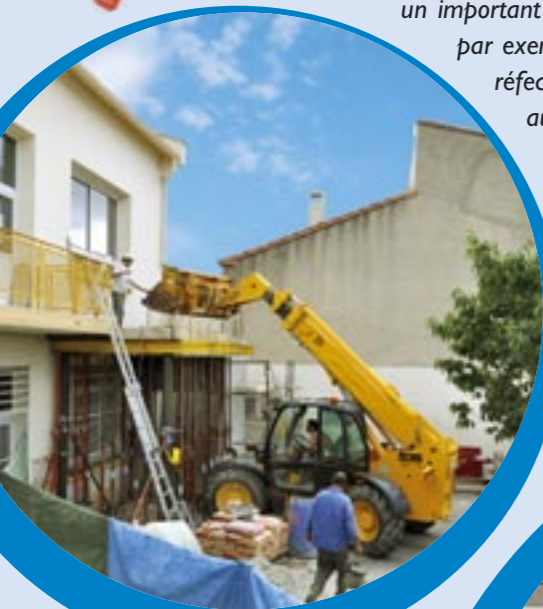
Un ascenseur a été réalisé cet été à l'école primaire du groupe scolaire Fénelon.
