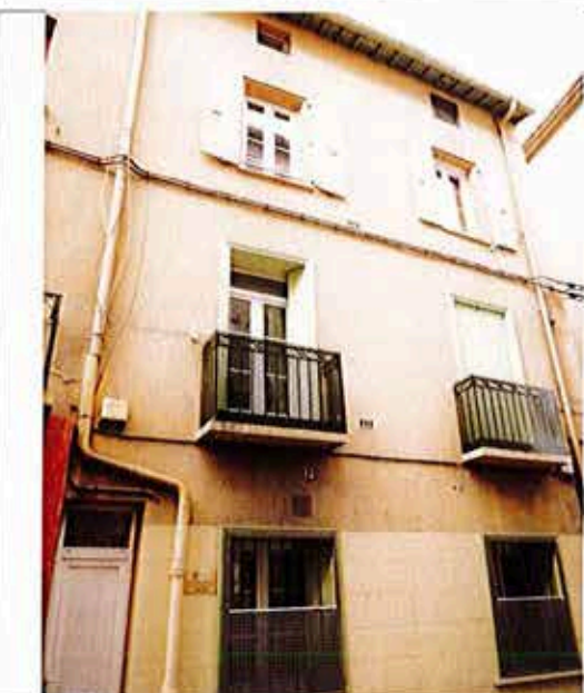
Porte latérale PVC et menuiseries
