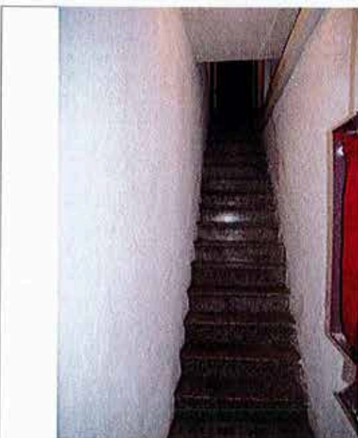
Escalier à volée droite en RdC
