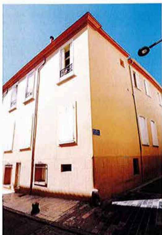
1, rue de l'Eglise la Réal
