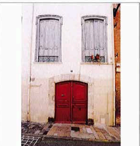
Détail de la travée d'entrée
