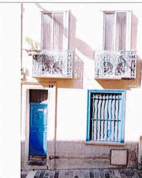
Détail des menuiseries et de la ferronnerie de la façade
