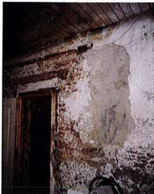
Ancienne porte intérieure brique avec linteau bois
