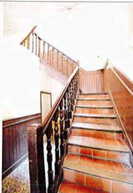
Escalier tournant suspendu garde-corps à balustres bois
