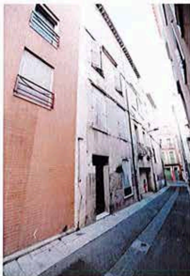
Façade rue du Pressoir
