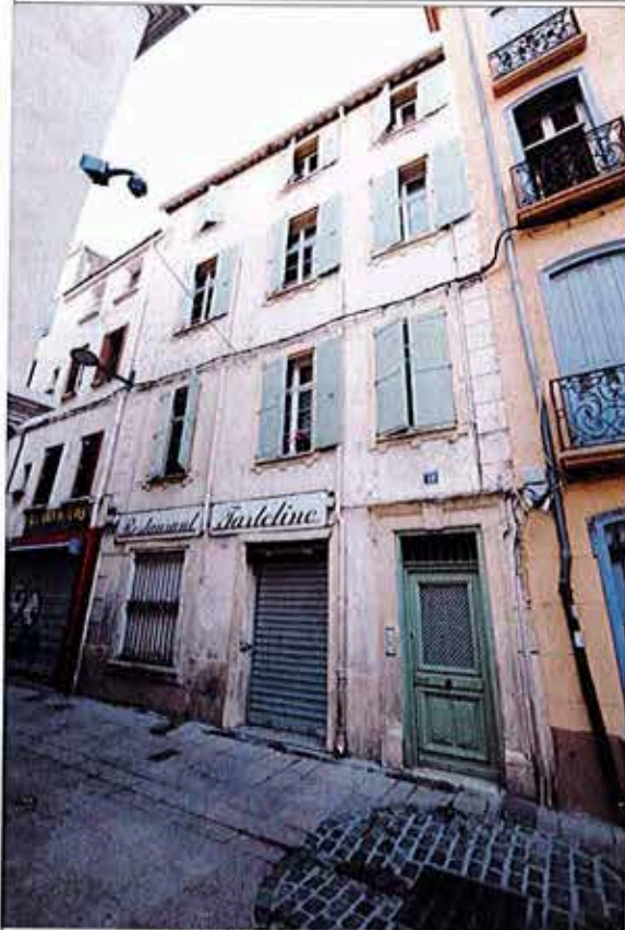
Façade rue Petite La Monnaie
