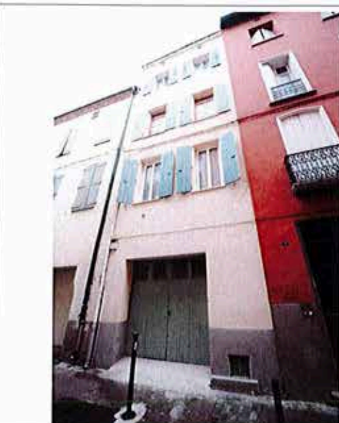
Façade côté rue Paul de Lamer
