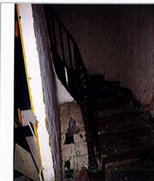
Départ escalier tournant suspendu
