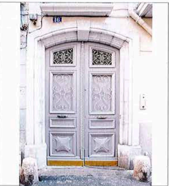
16 rue Saint Mathieu - Entrée rue
