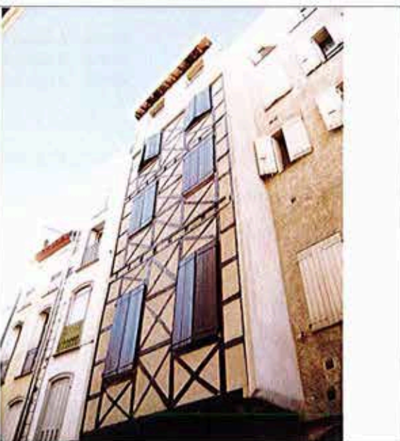
Façade après restauration
