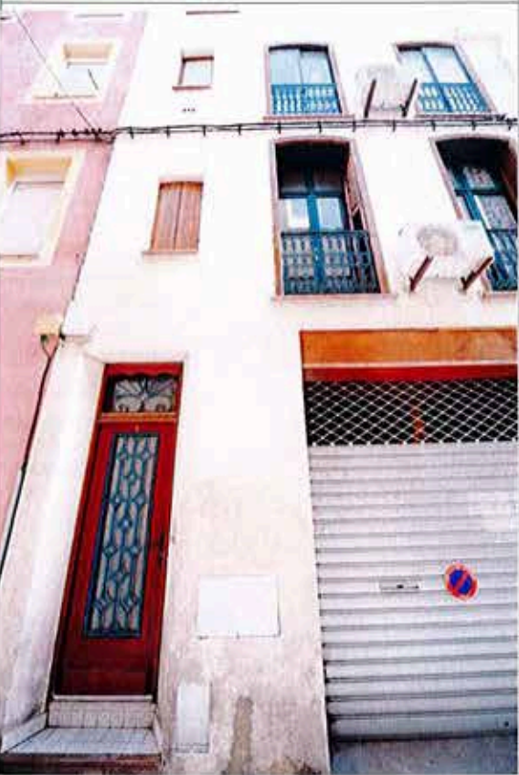
Rue Pierre de Marivaux
