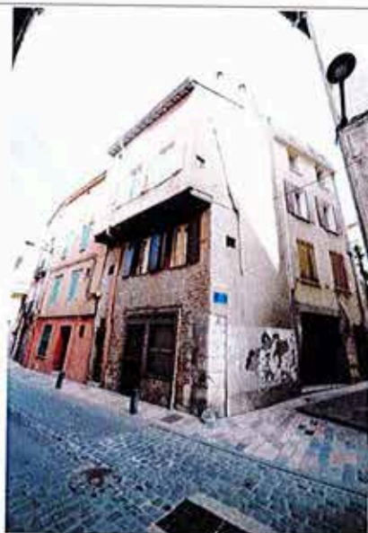
Angle de rue Grande la Réal et rue du pressoir
