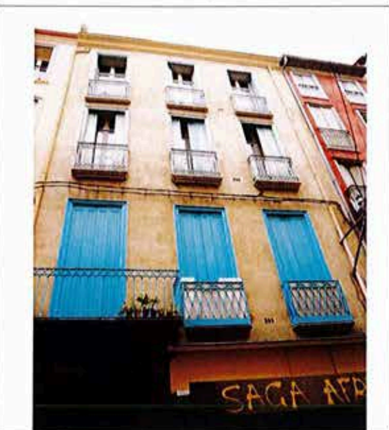
Détail des menuiseries et des ferronneries de la façade
