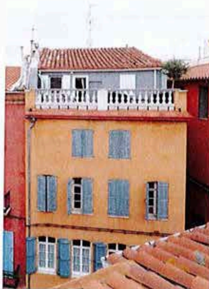
Vue de la terrasse
