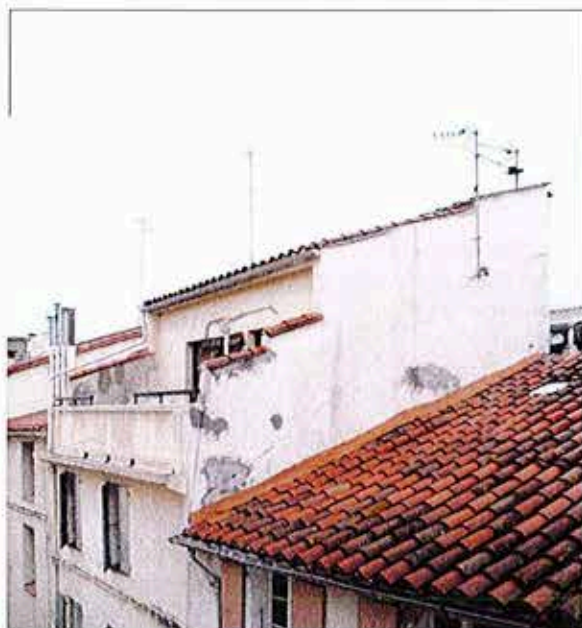
Surélévation (vue depuis AI 02-358: 22, rue Petite la Monnaie)
