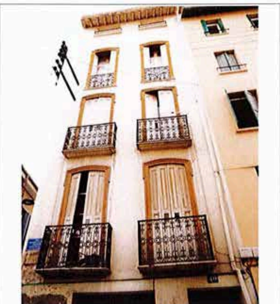
Détail des menuiseries et ferronneries de la façade
