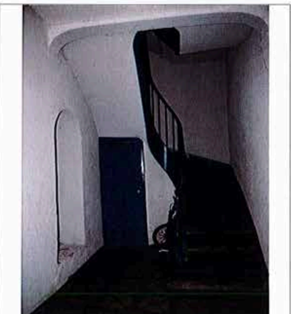
Escalier tournant suspendu à cage vide
