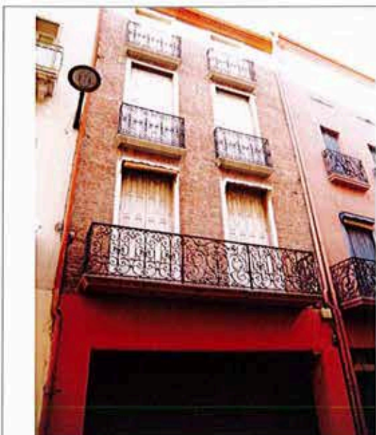
Détail des ferronneries du balcon & des balconnets
