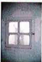
Communs et vues des combles
