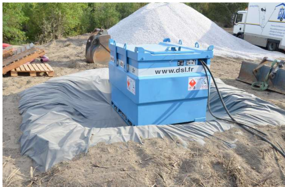
☞ Photographie 33 : : Mise en place d'une aire étanche autour d'un groupe électrogène
